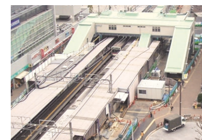
調布駅付近連続立体交差事業 (仮橋上駅舎に切替えた国領駅)
