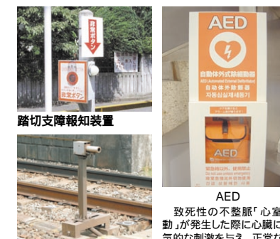
踏切支障報知装置 AED 致死性の不整脈「心室細動」が発生した際に心臓に電気的な刺激を与え、正常な状態に戻す装置
