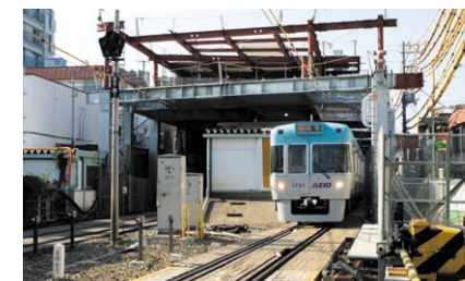
駅改良工事中の西永福駅
