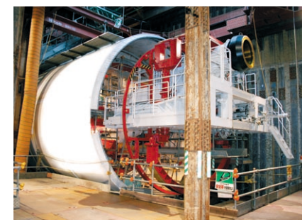
組み立てを完了したシールドマシン
