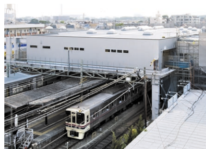
橋上駅舎化工事中の桜上水駅
