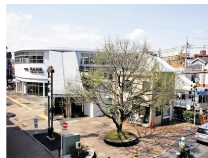
橋上駅舎化工事が完成した西永福駅
