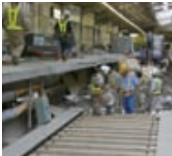
吉祥寺駅での工事の様子
