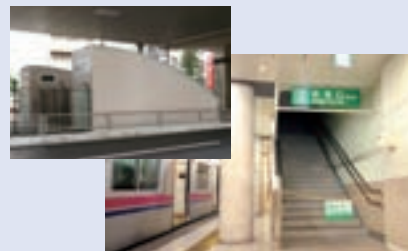
幡ヶ谷駅に新設された避難通路(下)と地上出口(上)
