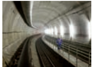
国領駅～調布駅間で掘進したトンネル部
