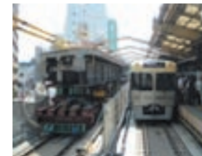
高架橋改築工事中の吉祥寺駅
