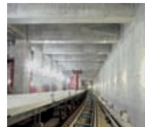
躯体築造と軌道敷設が進む調布駅
