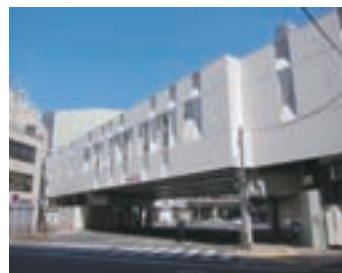
高架橋の改築が完了した吉祥寺駅
