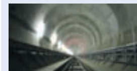
シールドトンネル
