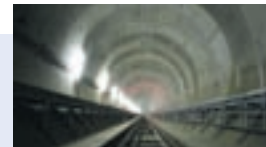
シールドトンネル
