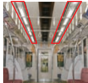
車内LED照明 (赤枠内)
