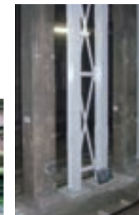
すい道中柱の耐震性向上
