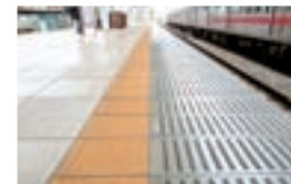
内方線付き点状ブロック
