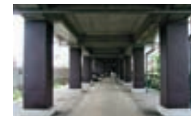
高架橋柱の耐震補強
