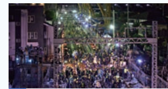
A 3カ所の線路切替えでは多くの作業員やクレーンを動員しました。(写真: 柴崎駅～国領駅間)
