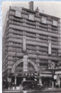
新宿ビルディング(日本社ビル)
