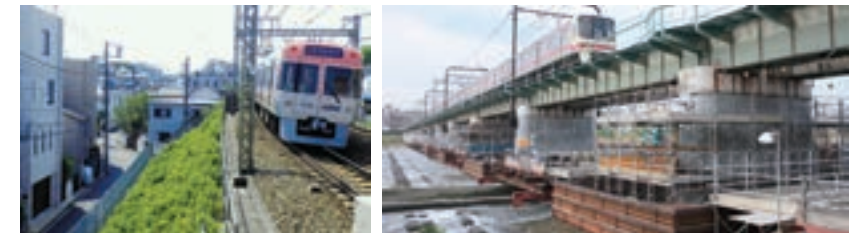
耐震補強を実施する盛土
