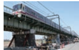
京王線多摩川橋梁耐震補強
