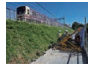
盛土区間を対象とした耐震補強
