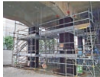
高架橋柱の耐震補強
