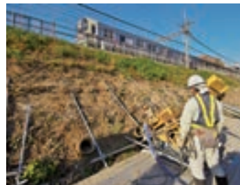
盛土区間の耐震補強
