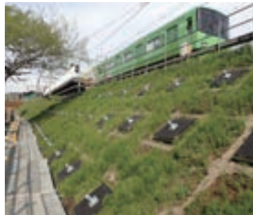
盛土耐震工事施工後
