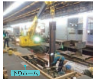
土留杭施工状況(第6工区)
