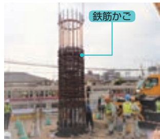
基礎杭施工状況(第2工区)
