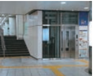
改札外エレベーター新設
