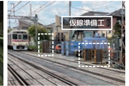
千歳烏山駅～仙川駅間 仮線準備工*
