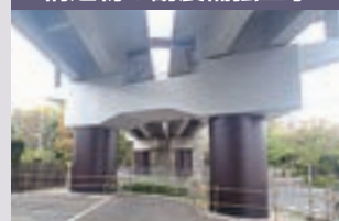
耐震補強工事を行った高架橋柱 (京王多摩センター駅付近)
