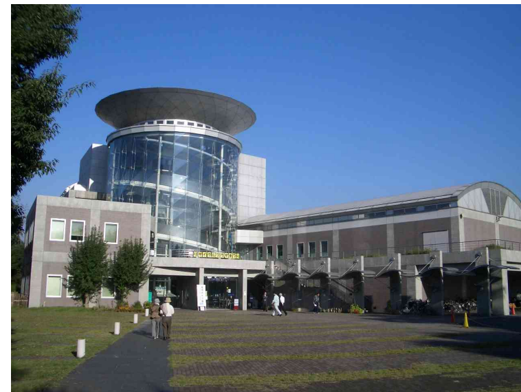
八王子市北野余熱利用センター
