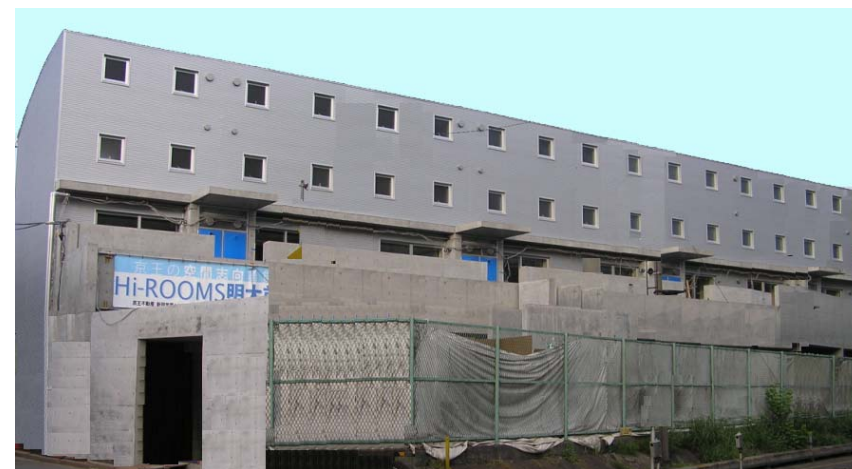
Hi-ROOMS明大前工事現況
