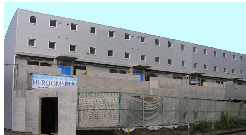
Hi-ROOMS明大前工事現況
