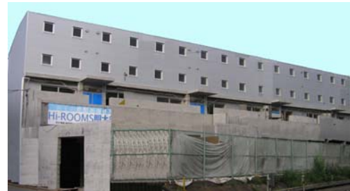
Hi-ROOMS明大前工事現況
