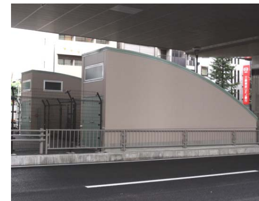
完成した幡ヶ谷駅緊急避難階段
