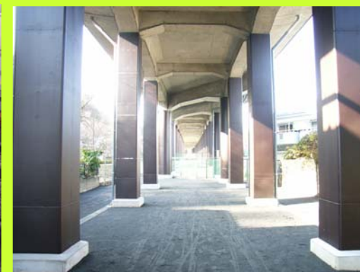
補強が完成した高架橋柱
