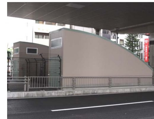
完成した幡ヶ谷駅緊急避難階段
