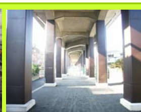
補強が完成した高架橋柱
