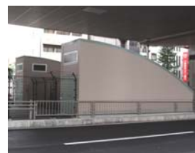
完成した幡ヶ谷駅緊急避難階段
