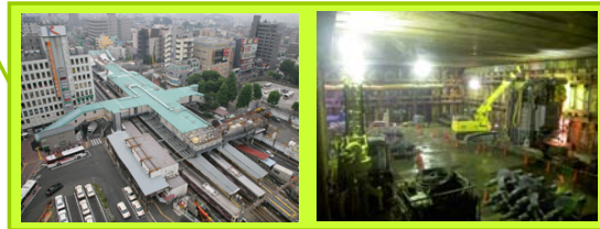
調布駅仮橋上駅舎（左上） 調布駅の線路下の掘削状況（右上）
