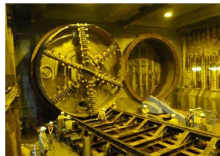
調布駅西側立坑に到達したシールドマシン(相模原線掘進完了)
