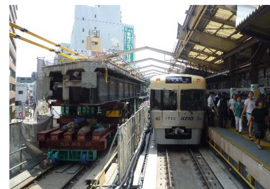
高架橋改築工事中の吉祥寺駅
