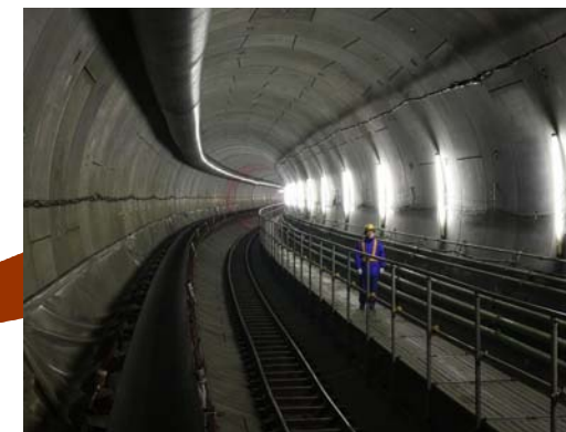
国領駅～布田駅間のシールドトンネル
