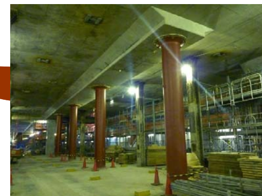
躯体の築造が進む調布駅(地下2階)
