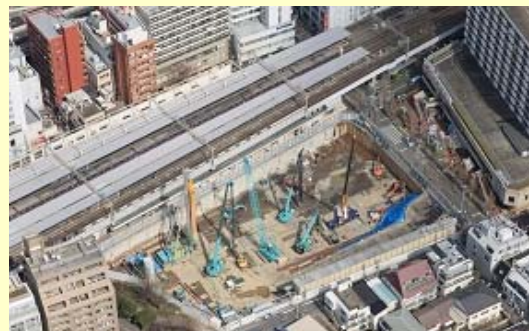
新築工事現場
