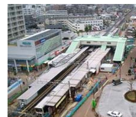
地下化切替前の駅舎
