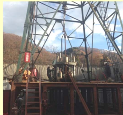
ボーリング工事中
