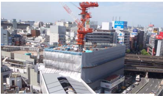
解体工事と新築工事を並行して推進 (2012年8月時点写真)
