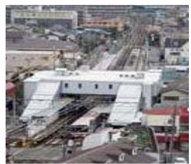
地下化切替前の駅舎
