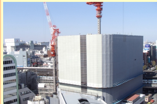
解体工事と新築工事を並行して推進
