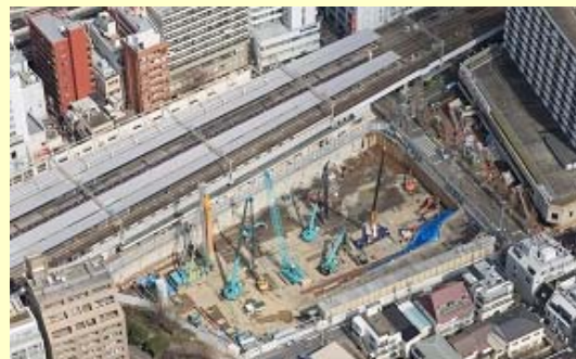
新築工事現場
