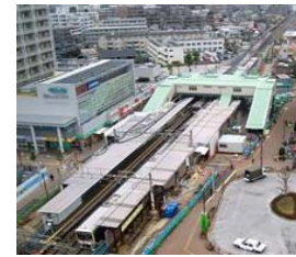
地下化切替前の駅舎
