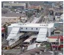
地下化切替前の駅舎
