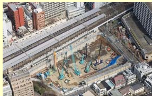
新築工事現場
