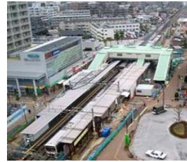
地下化切替前の駅舎
