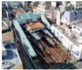
地下化切替前の駅舎
