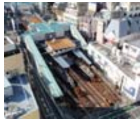
地下化切替前の駅舎
