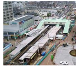
地下化切替前の駅舎
