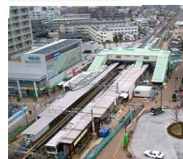
地下化切替前の駅舎
