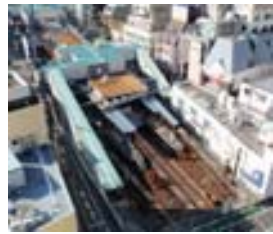
地下化切替前の駅舎
