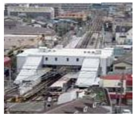
地下化切替前の駅舎
