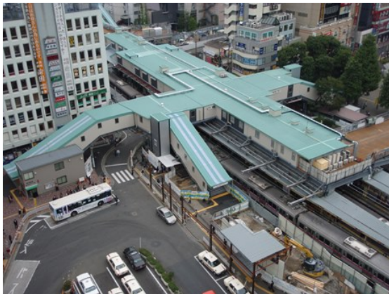
地下化切替前の駅舎
