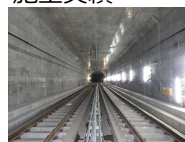
相鉄・JR直通線 西谷トンネル建設工事(軌道関係)
