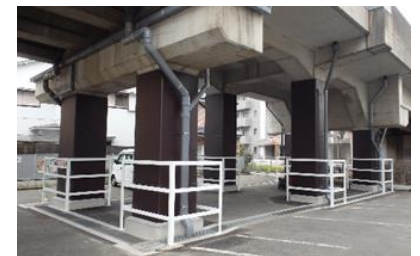
《高架橋耐震補強工事》
