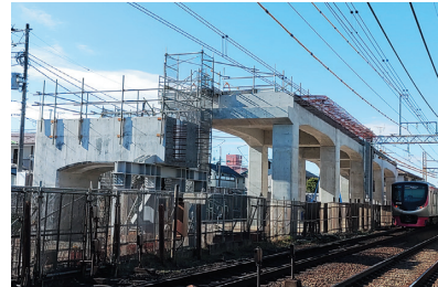
京王線連続立体交差事業
