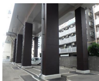
《高架橋耐震補強工事》
