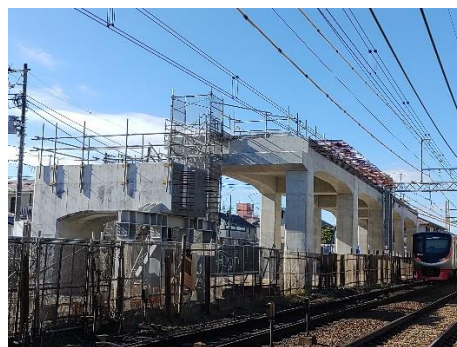
《一部完成した高架橋躯体（明大前駅付近）》
