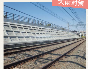
線路脇斜面改修 (北野駅~京王片倉駅間)
