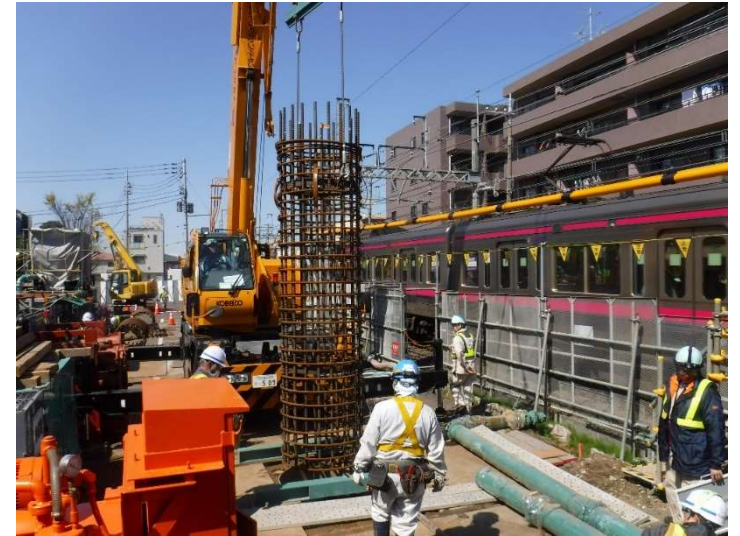
鉄筋かご建込み状況 (千歳烏山駅～仙川駅間)
