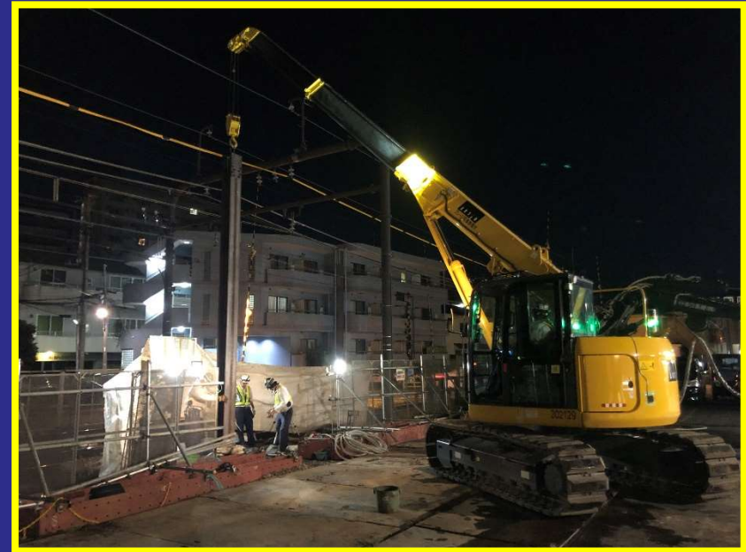
土留杭設置状況 (明大前駅付近)
