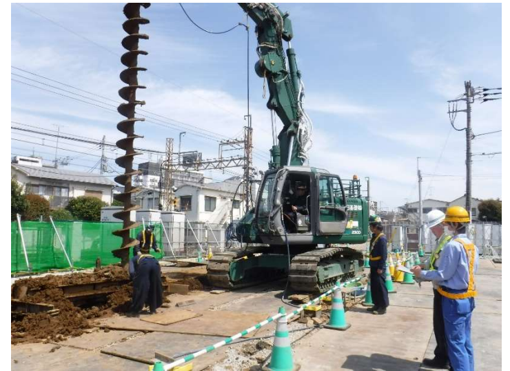
土留杭設置状況 (明大前駅付近)
