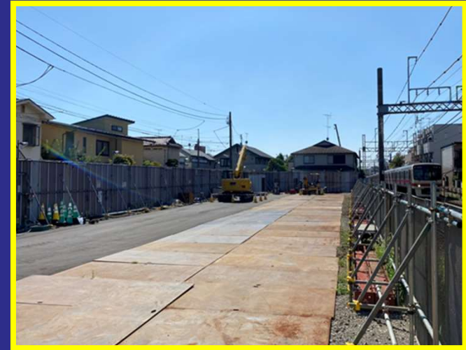
ヤード整備工
