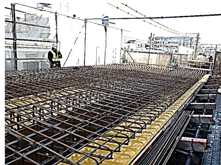
鉄筋組立て状況の例
