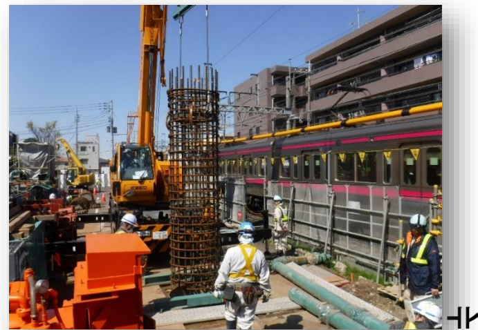
鉄筋かご建込み状況 (千歳烏山駅～仙川駅間)
