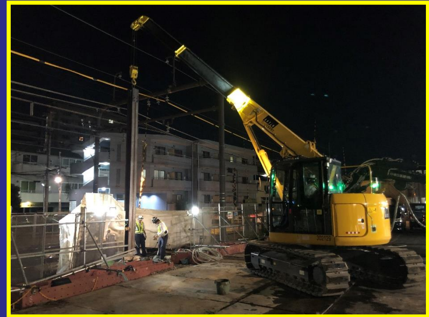
土留杭設置状況 (明大前駅付近)
