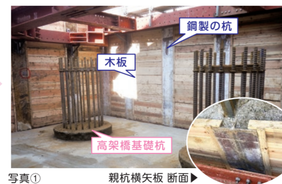
写真① 親杭横矢板 断面
