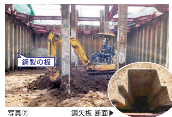
写真② 鋼矢板 断面
