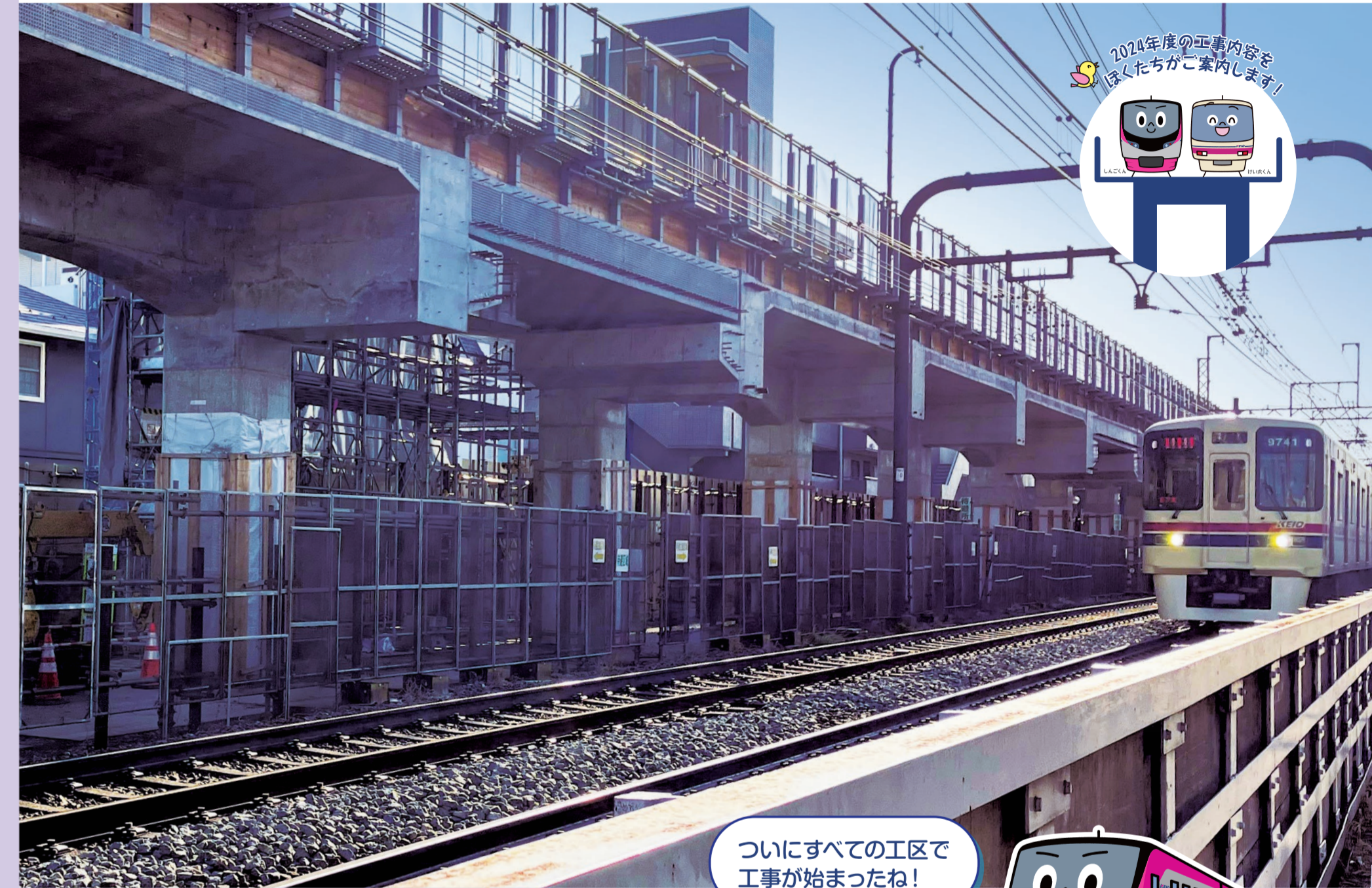
写真:第8工区(千歳烏山駅～仙川駅間)
