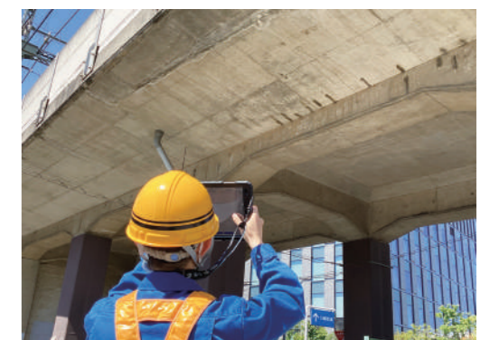
タブレットによる現場での検査
