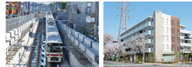
調布駅付近地下化切替工事 スマイラス聖蹟桜ヶ丘（サービス付き高齢者住宅）
