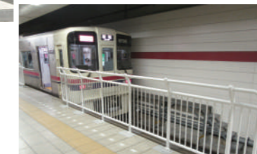
転落防止固定柵
