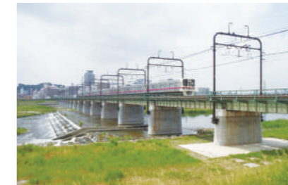
多摩川橋梁耐震補強
