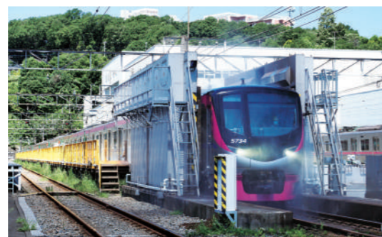
節水型車両洗浄装置
