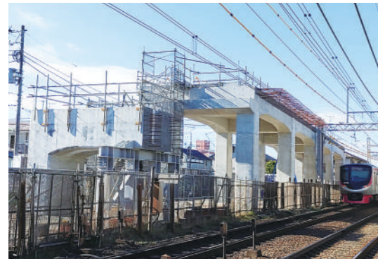
高架橋構築箇所(明大前駅付近)
