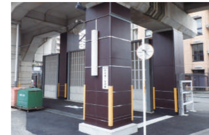
高架橋柱耐震補強
