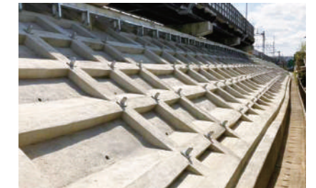
盛土区間耐震補強
